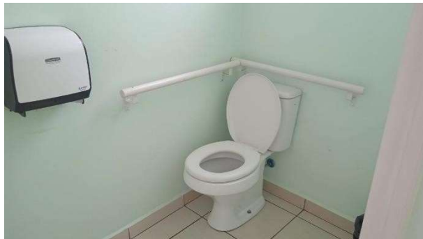
Barras nos banheiros
