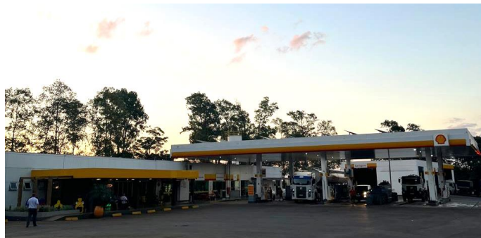
Ilustração 1: Fachada do posto de combustível em 2024.
