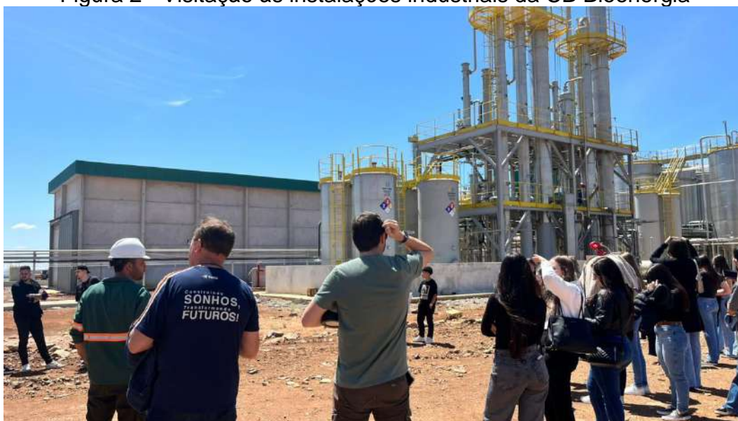
Figura 2 - Visitação às instalações industriais da CB Bioenergia
