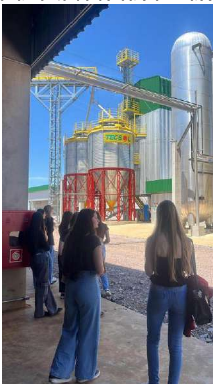
Figura 3 - Silos de armazenamento de cereais e infraestrutura da planta industrial
