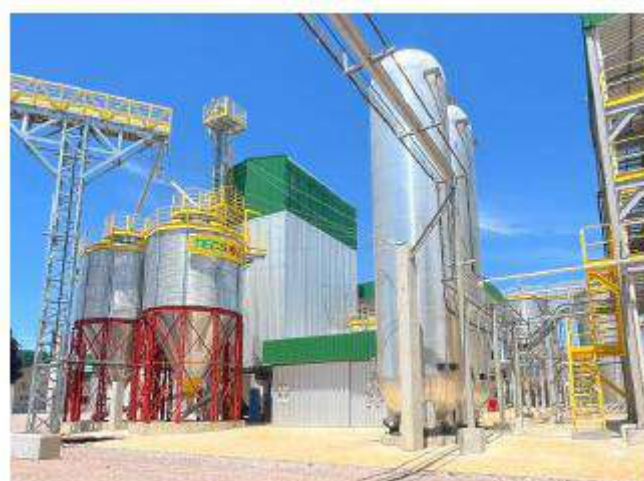
Figura 4- Usina CB Bioenergia
