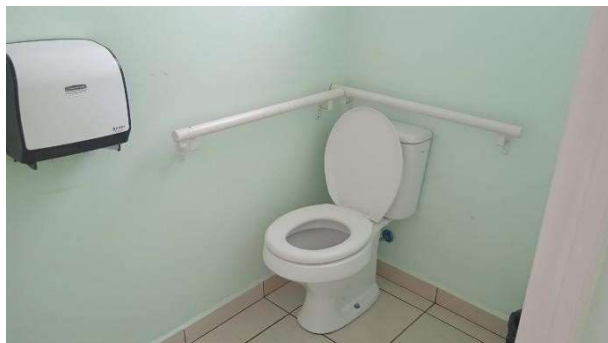
Barras nos banheiros
