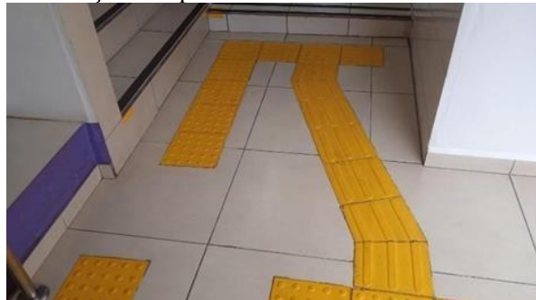
Sinalizações no piso
