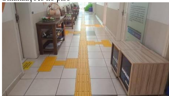
Sinalizações no piso
