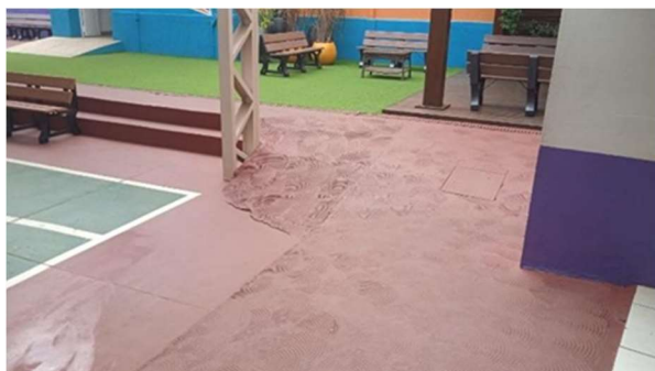
Rampa de acesso
