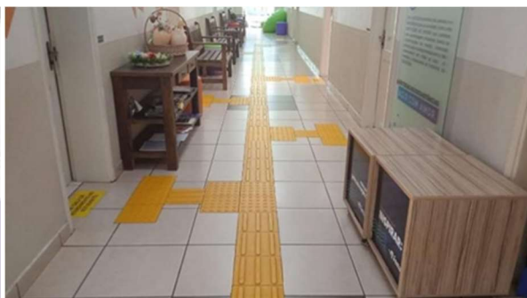
Sinalizações no piso
